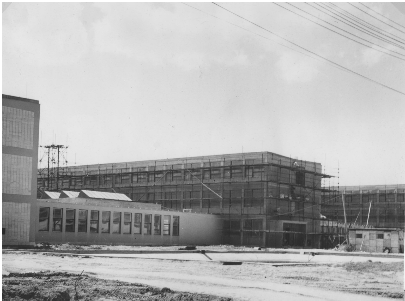
Výstavba TF - rozestavěný přední trakt TF. Foto z roku 1963 z vozovky od auly k TF před požární nádrží.
