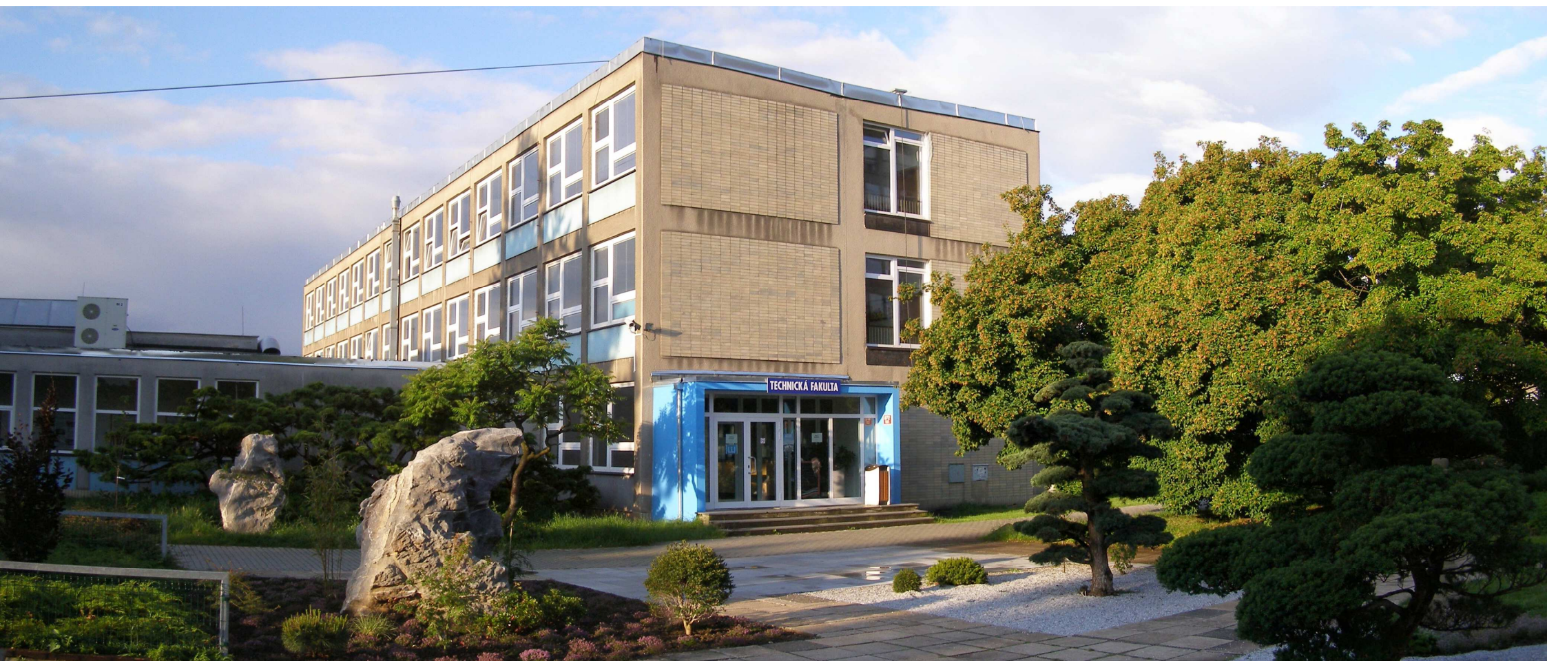
TF před zateplením pláště budovy, 2009.
